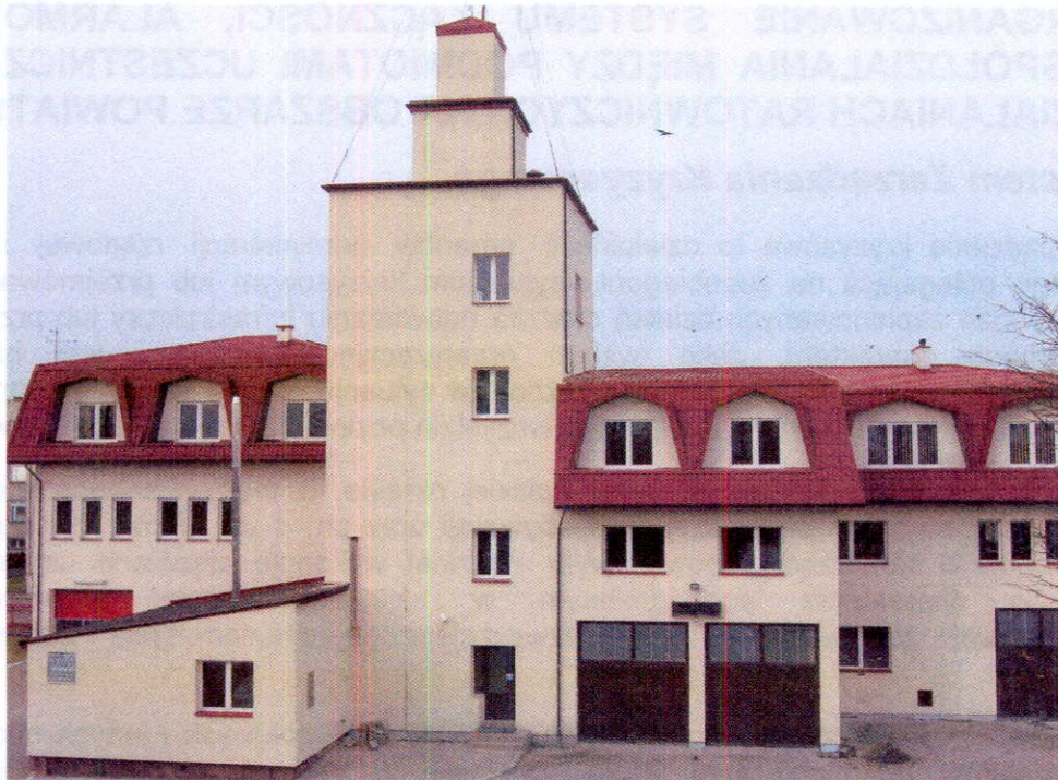
Widok ogólny Komendy od strony placu po wykonaniu II etapu rozbudowy strażnicy
